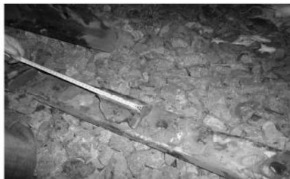
Foto 3 : Fragmentul rupt din șină
