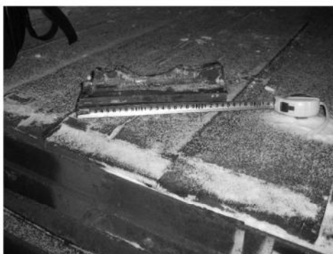
Foto nr.4 Fragmentul rupt din șină
