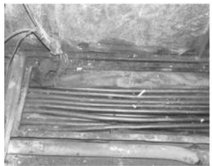
Fig.15 Cablaj de forță din canalul cu cabluri pe lungimea cutiei locomotivei
